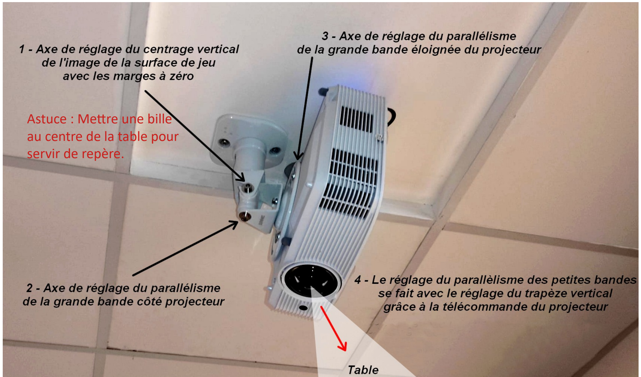
Exemple d'installation du support sur une plaque en bois intégrée au faux plafond avec le projecteur OPTOMA HD29HSTx
